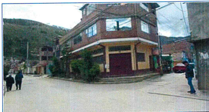
INSPECCIÓN - JUNIO DEL 2023
